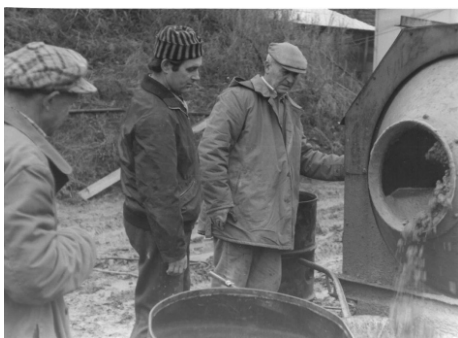
Brigádníci při stavbě MŠ
